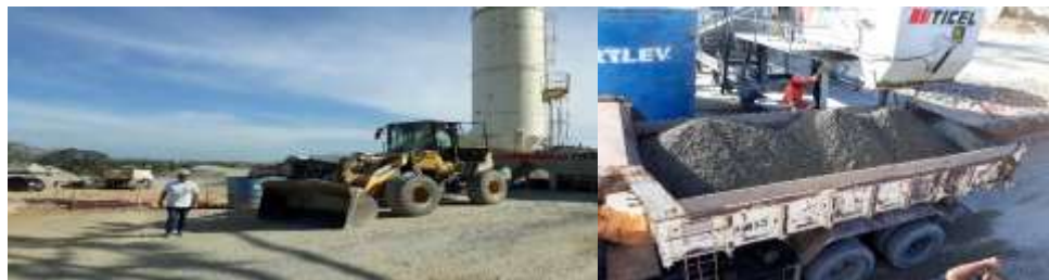
Figura 3: Produção de concreto CCR na Usina.
