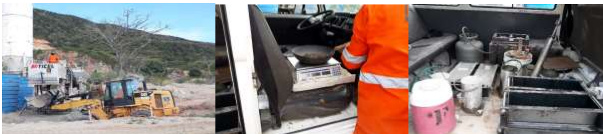
Figura 4 – Ajuste de Umidade do traço concreto CCR na usina.
