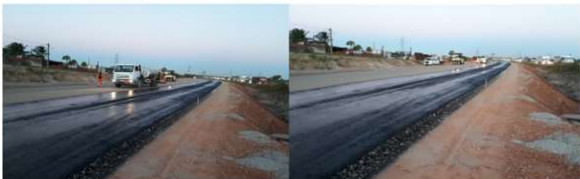
Figura 9: Processo de imprimação de concreto CCR em pavimentação.
