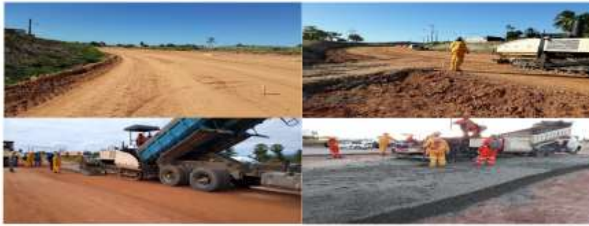
Figura 7: Execução de concreto CCR em pavimentação
