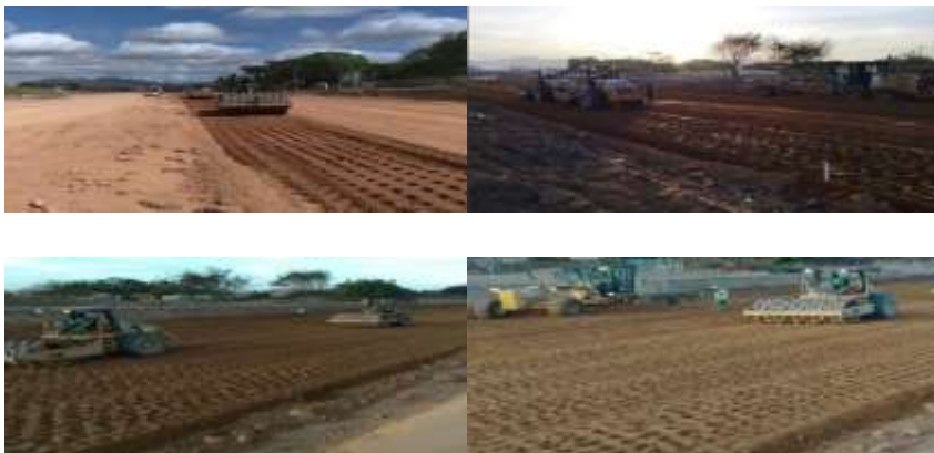
Figura 1: Terraplanagem – Trecho Distrito Industrial Maracanaú – CE.
