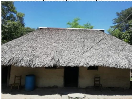
Fig. 4.- Vivienda muros de oate en la comunidad Malilijá. Municipio de Tanlajás.
