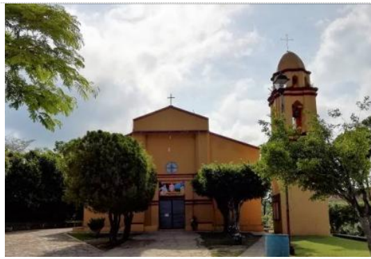
Fig. 3.- Fachada del templo de Santa Ana, Tanlajás
