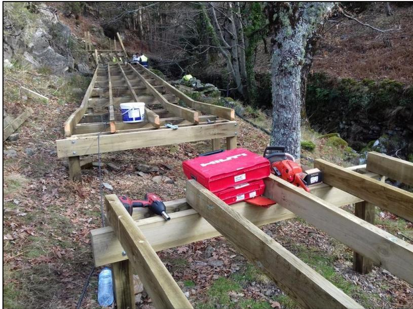
Figura 42. Início da construção do Passadiço das Quelhas (12/2019)
