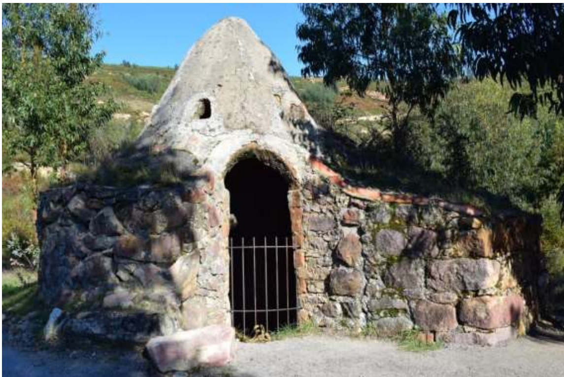
Figura 97. Antigo forno de cal parda em Alveite Grande (Vila Nova de Poiares, 11/2021)
