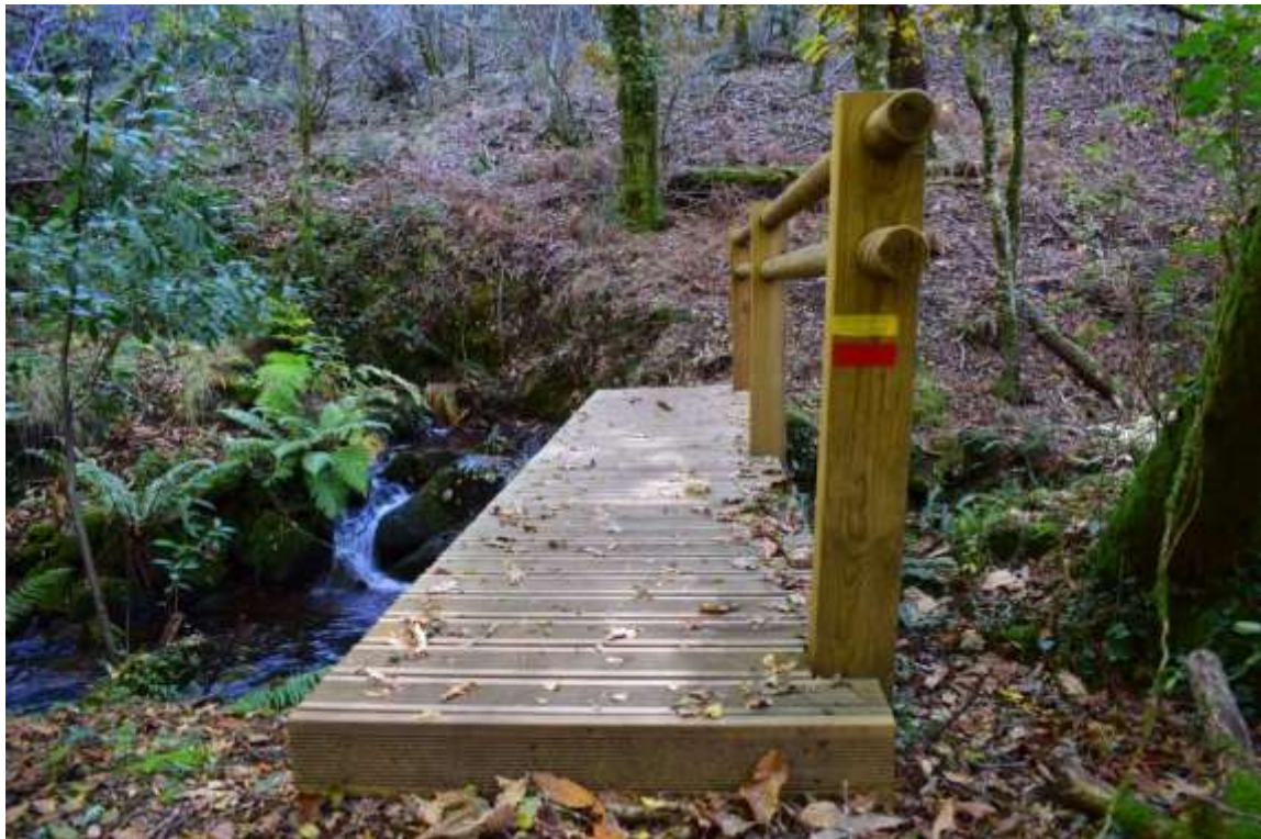
Figura 54. Ponte de madeira no PR2 PNL (Penela, 11/2021)
