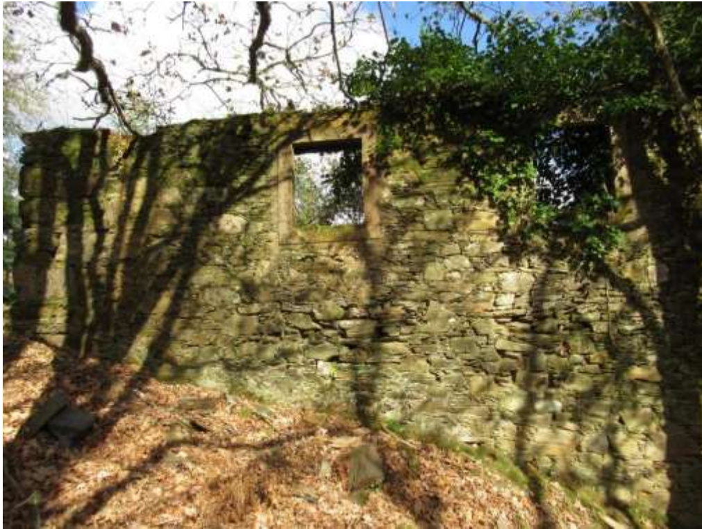
Figura 71. Ruína de antiga habitação no Franco de Baixo (Lousã, 01/2019)
