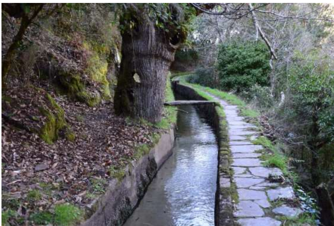
Figura 44. Troço da levada da central hidroelétrica da Ermida (Lousã, 02/2022)
