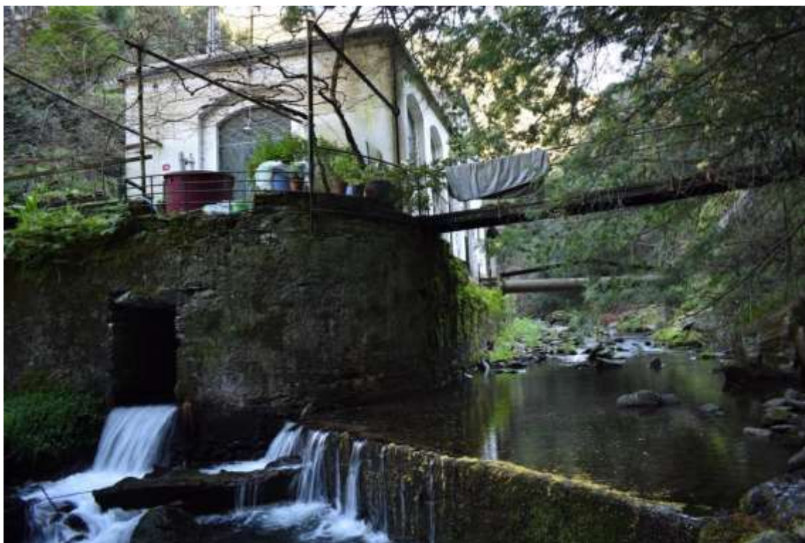
Figura 43. Central hidroelétrica da Ermida (Lousã, 11/2021)
