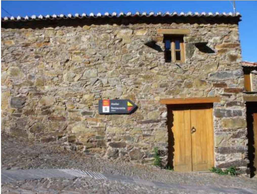
Figura 47. Pormenor (piso) do percurso pedestre acessível do Gondramaz (Miranda do Corvo, 05/2021)
