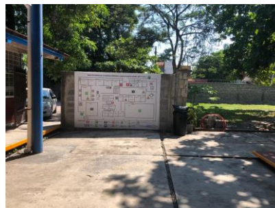
Figura 3. Instalación de mapa de riesgos de la institución. Fuente: Propia
