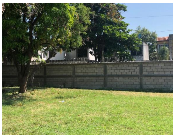
Figura 6. Barda Perimetral con concertina. Fuente: Propia
