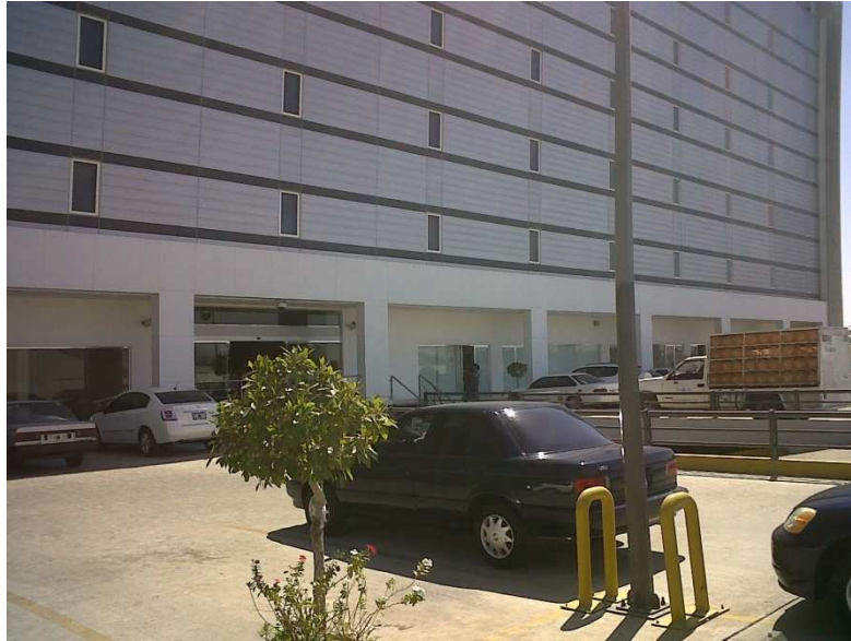
Vista trasera del edificio Country Courts.
