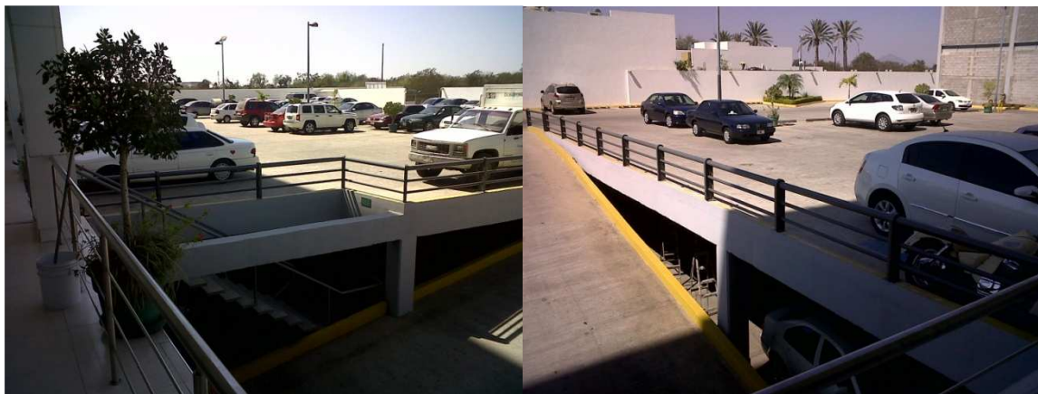
Estacionamiento trasero del edificio Country Courts, en donde se ubica la CEAIPES.
