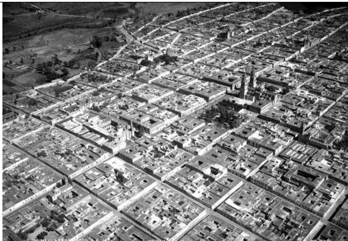
Fig. 7.- Imagen del conjunto de Morelia hacia el Norte. 1940 . Se puede apreciar en la esquina superior izquierda el poblado de Santiaguito con su templo. El límite de la ciudad era la vía del ferrocarril, actualmente la av. Héroes de Nocupetaro. En la parte superior derecha se aprecia la antigua plaza de toros en la actual calle de Aquiles Serdán. Fotografía tomada por la compañía mexicana aerofoto, S. A. consultad el 20 de diciembre de 2016 en https://www.facebook.com/MoreliaATravesDelTiempo/photos/a.382086011884607.91492.342684702491405/383276718432203/?type=3&theater
