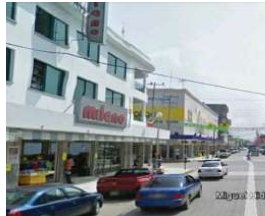
Ilustración 12 Punto S3. Fuente; elaboración propia.
