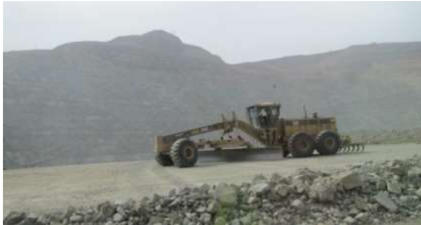
Figura 2 – Escarificação da via de acesso
