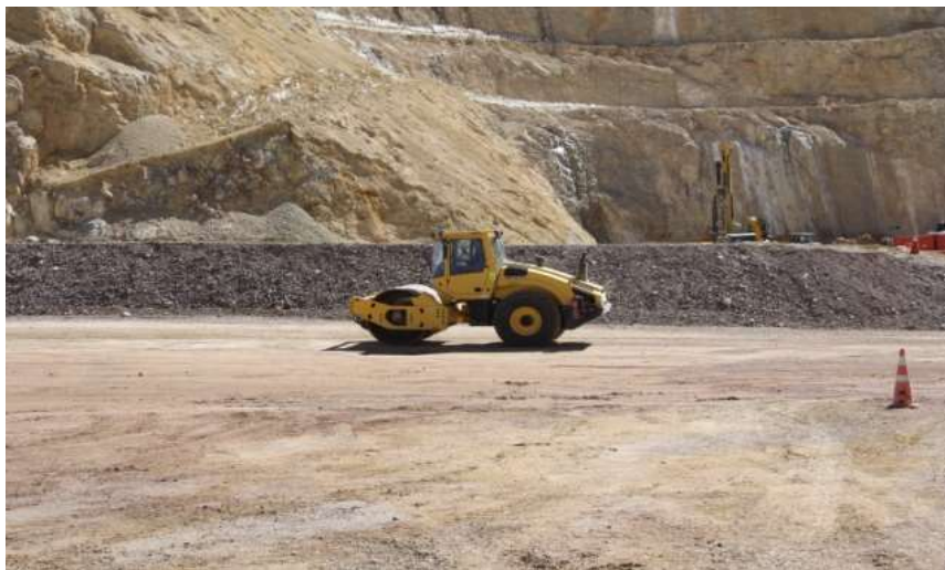
Figura 3 – Compactação do solo
