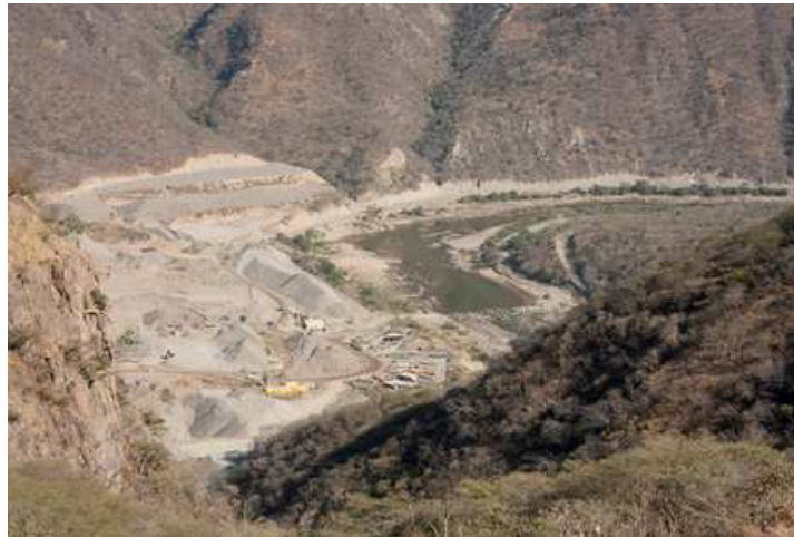
Figura 1. Obra de construcción de la presa La Yesca.
