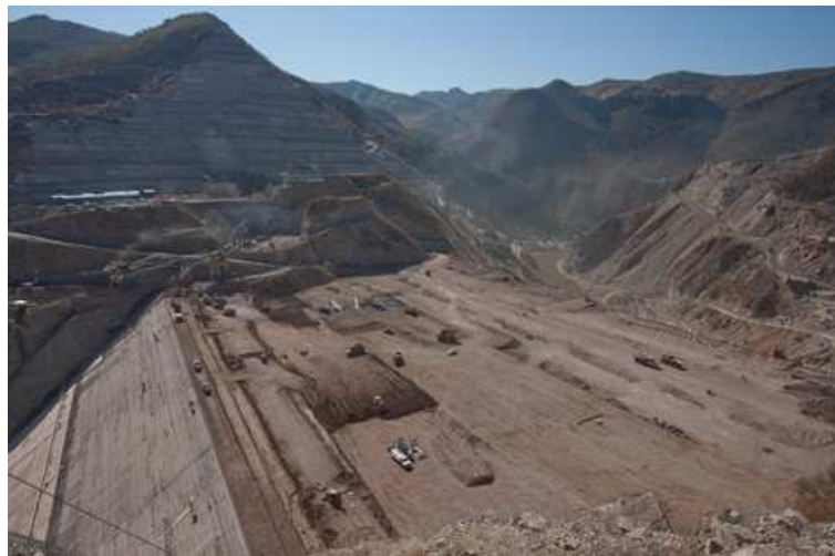
Figura 2. Obra de construcción de la cortina de la presa La Yesca.
