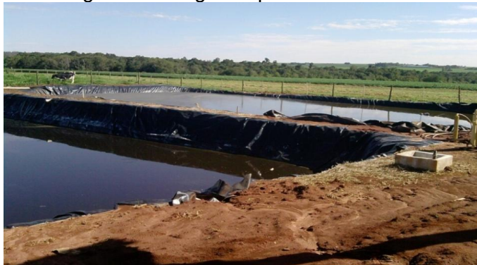
Figura 5 – Lagoa do biodigestor para armazenar biofertilizante
