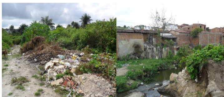
Imóveis fronteiriços em situação de risco e poluição de nascentes
