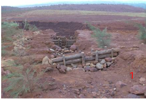
Figura 4. Obra de ingeniería: Dique combinado con postes de madera y rocas (1) y Método de Barreras de ramas (2) (Fotos: Fuente propia).
