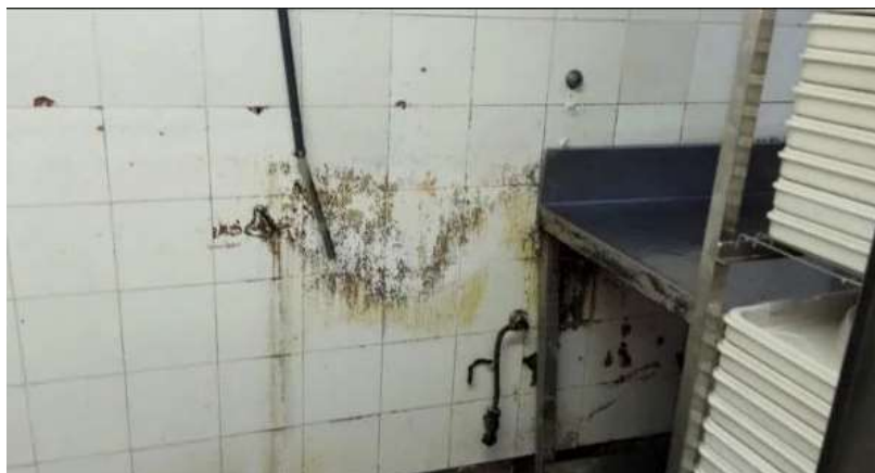
Figura 1. Consecuencias de no utilizar acero inoxidable AISI 304 en la fabricación de mobiliario para hospitales (L. Díaz, 2019).
