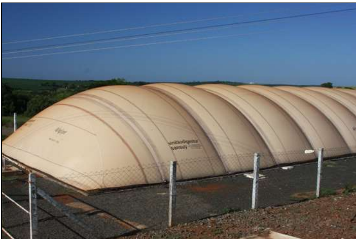
Figura 5 – Biodigestor tipo indiano, esse tipo é o mais utilizado na suinocultura. Fonte: Barichello, (2015).
