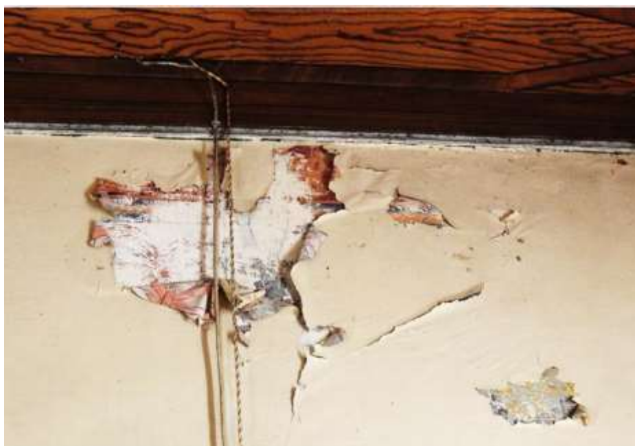
Figura 18: Detalhe do descolamento de tinta na parede da sala de recepção. Serro Formoso. 2017. Fonte: Acervo da autora.
