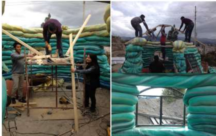
Figura 4 Construcción del domo Fuente: Autores
