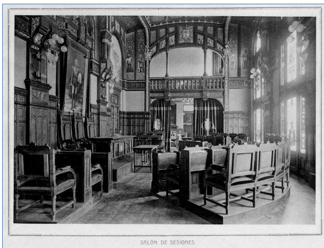
Fig. 2. Salón de Plenos (actual Salón de la Constitución). Palacio Provincial, Oviedo. Archivo Municipal de Oviedo.
