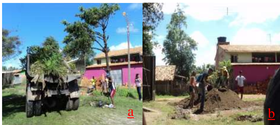
Figura 3 – Aspectos de revitalização com roçagem capina e retirada de resíduos do local (a); e colocação de aterro nas poças d'água para nivelamento (b).
