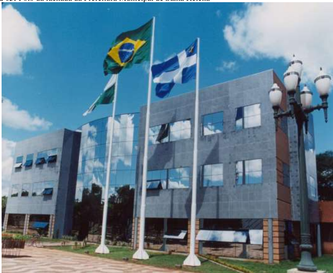
Figura 03: Foto da fachada da Prefeitura Municipal de Santa Helena
