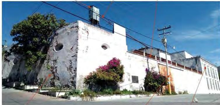
Muros de adobe y piedra, recubiertos con argamasa.
