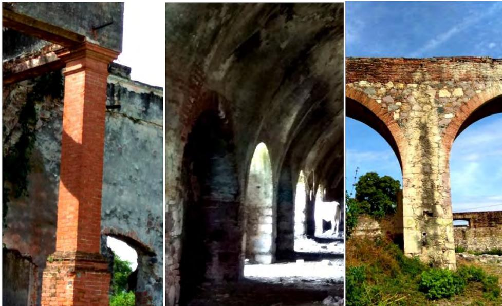
Imagen 11. El pilar esbelto o robusto es la constante como soporte vertical en él se apoya, vigas de acero, bóvedas de cañón o arcos Fuente. García Salazar R. (2017)
