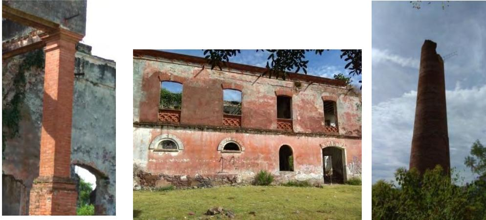
Imagen 14. El tabique de barro recocido, colocado al natural destaca en pilares, arcos, antepechos y chacuacos
