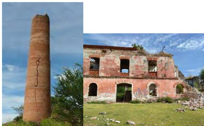
Imagen 17. Deterioros por sismo, agrietamientos, desplomes de muros
