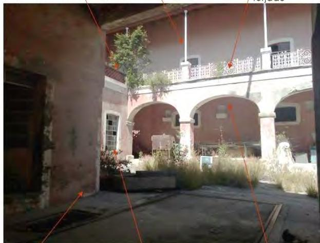
Muros de adobe y piedra, recubiertos con argamasa.
