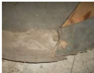
De izquierda a derecha. Fig. 1. Muestra presencia de insectos y eflorescencias de oxidación activa en cucharilla de fundición.
