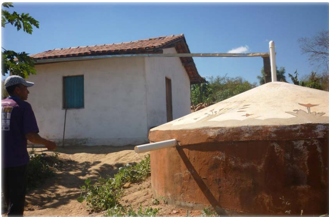
Figura 4: Sistema de coleta de águas pluviais. Projeto do CPCD.
