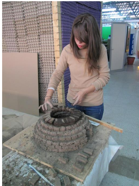
Construcción de bóveda circular escalonada Foto: Rafael González Alejo.
