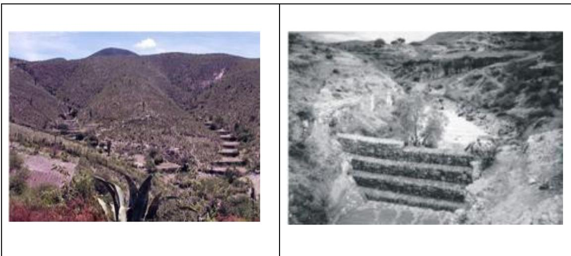
En la cara de la represa que está corriente arriba se amontonan ramas, tierra o desechos vegetales disponibles que impidan que el agua se filtre velozmente, logrando un estancamiento temporal. Ante el peligro de que los afluentes derribasen un muro de piedra acomodada, en determinados lugares donde los arrastres pudieran ser más fuertes, se ha propuesto adamas la construcción de
