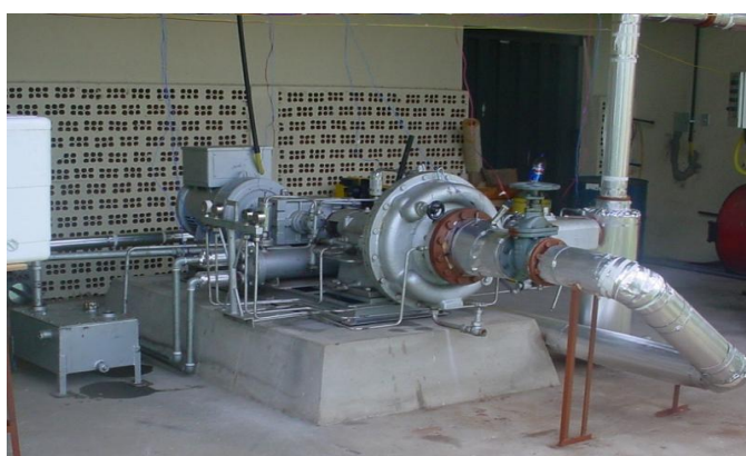
Figura 07: Turbina Assentada sobre a Base Inercial com todos os seus Acessórios e
