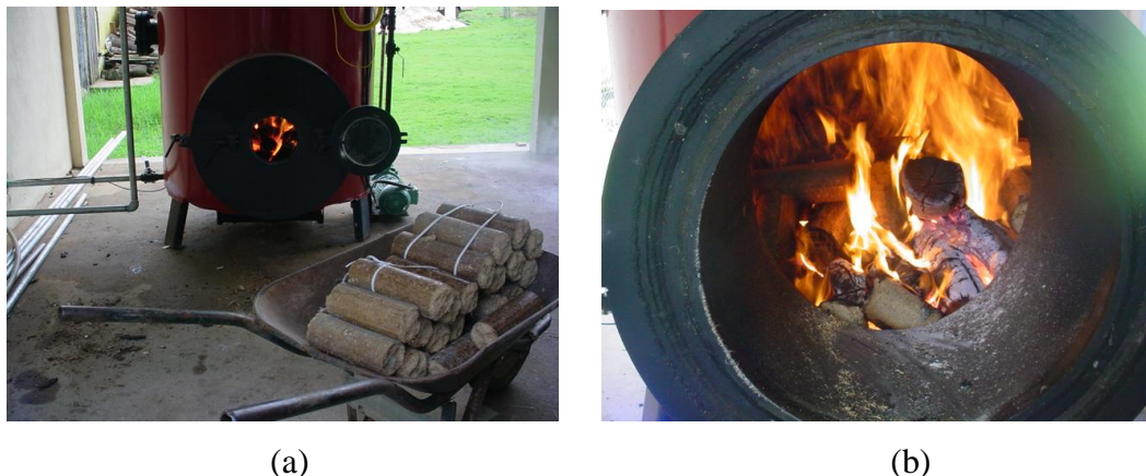
Figura 08: Queima do Briquete na Fornalha da Caldeira. (a) Vista da Câmara de Combustão e Briquetes (b) Briquetes no Interior da Câmara de
