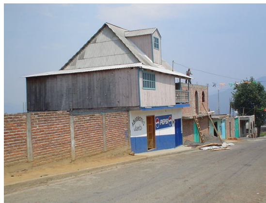
Figura 3. La sustitución de materiales tradicionales por contemporáneos, es una de las principales transformaciones de la vivienda. Fuente: Fotos del autor
