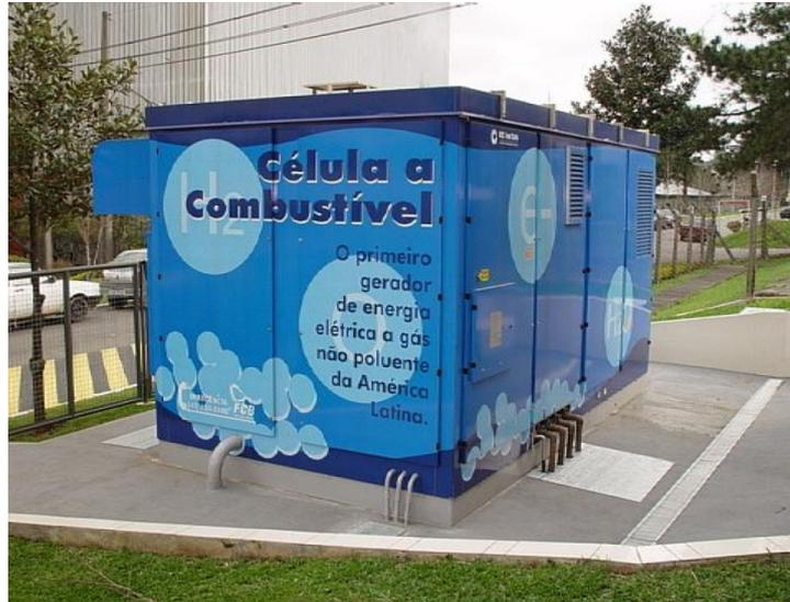
Figura 4.11: Célula a combustível movida a hidrogênio.
