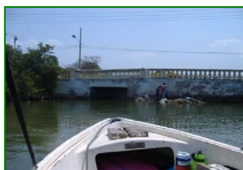
Figura 41. Estrangulamiento del Caño Bazurto por la construcción del puente Las Palmas
