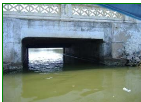
Figura 41. Estrangulamiento del Caño Bazurto por la construcción del puente Las Palmas
