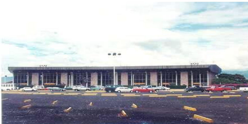
Entrada Principal al Aeropuerto de la Ciudad de Oaxaca.
