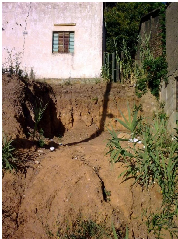
Figura 9 - Detalhe da retirada de terra sem o devido tratamento para receber os esforços da construção.
