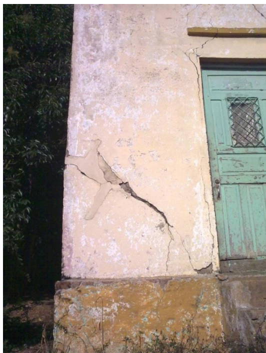
Figura 7 - Detalhe da rachadura da alvenaria causada pelo recalque das fundações
