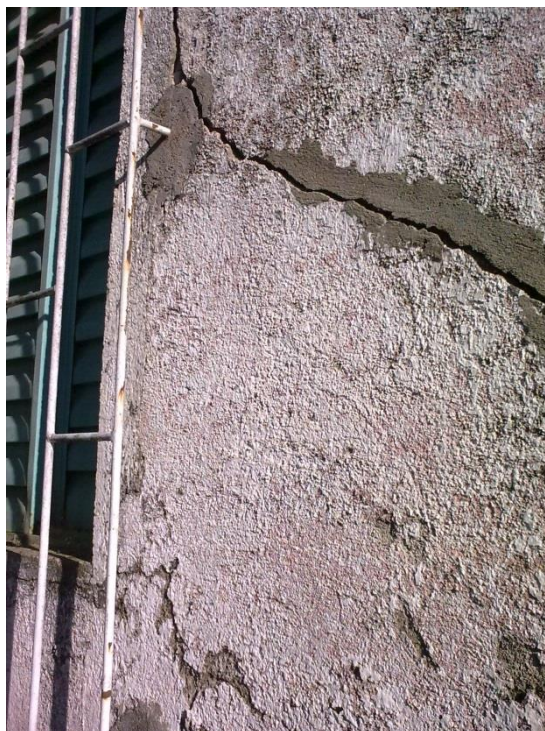
Figura 7 - Detalhe do prédio (fundação inadequada para receber os esforços, ocasionados pela movimentação do terreno e estrutura inadequadas).
