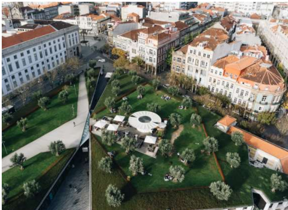
Figura 2 – Telhado Verde na Cidade do Porto
