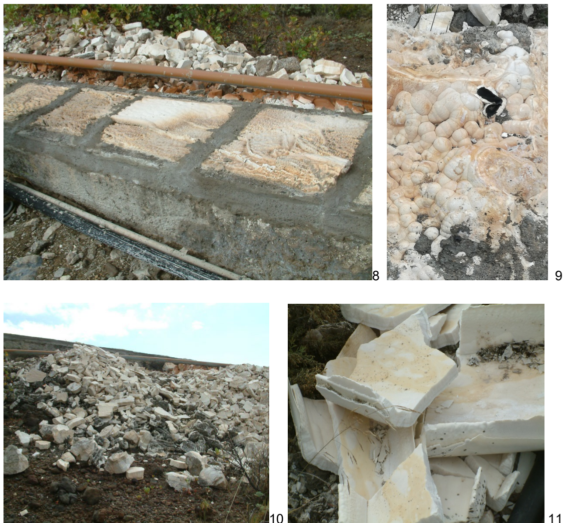
Fig.8: Canal de mampostería (Galería el Rebosadero-Arico-Tenerife). Fig. 9: Detalle de petrificaciones formadas en la zona interna de una tapa del canal. Figura 10: Escombrera acumulada junto al canal. Fig. 11: Detalle de residuos líticos de la escombrera.
