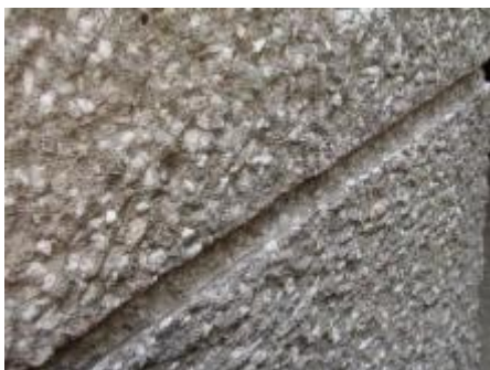
Ilustración 138 UPN Simulación de sillería en junta constructiva. Foto Susana
