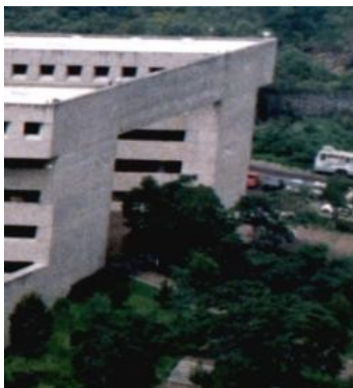
Ilustración 187 UPN Trabe para unir los edificios al final, cerrando estructura. Foto LAG
