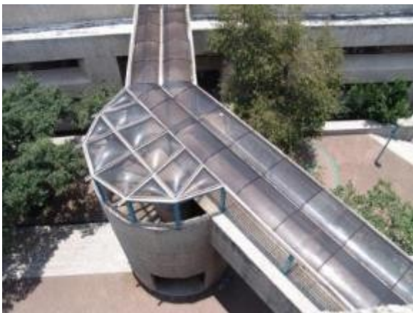
Ilustración 425 UPN Cubierta de acrílico en puente peatonal. Foto VRS
