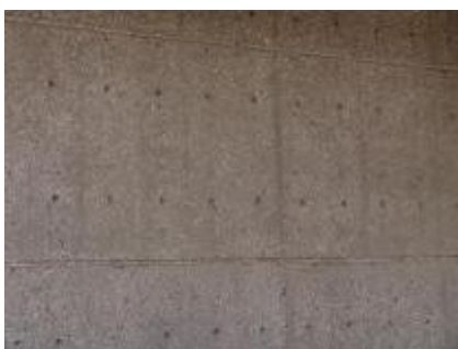
Ilustración 134 UPN Juntas constructivas, chapetones y sillería. Foto VRS
