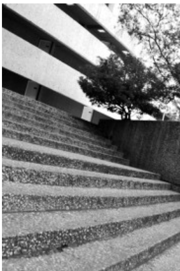
Ilustración 143 UPN Adocreto en escalones, énfasis en color y textura. Foto Basilio
