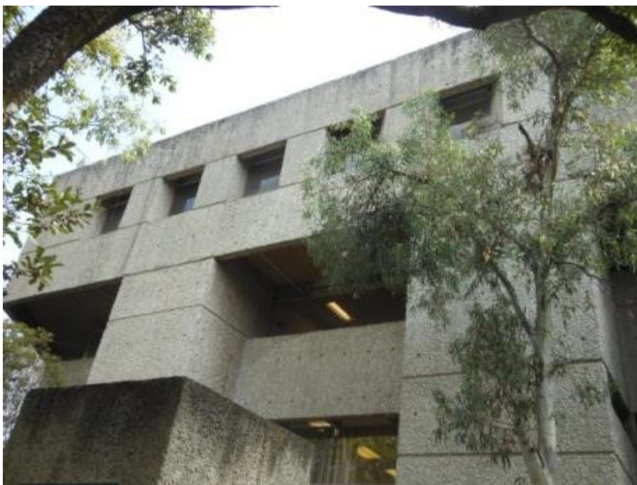
Ilustración 179 UPN Fachada tipo pórtico: viga, columnas y vano. Foto VRS
