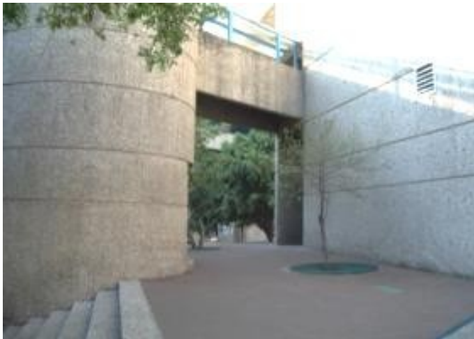
Ilustración 142 UPN Toda la superficie de muros externos es de adocreto. Foto VRS
