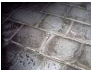
Fotografía 4: Piso de lajas de piedra, parroquia Nuestra Señora del Rosario, las que denotan su antigüedad, fotografía tomada por la autora en noviembre 2011.
