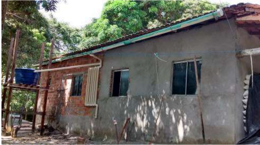
Figura 7 – Sistema de captação de águas pluviais em residência na vila de Cuiarana, Salinópolis-PA.
