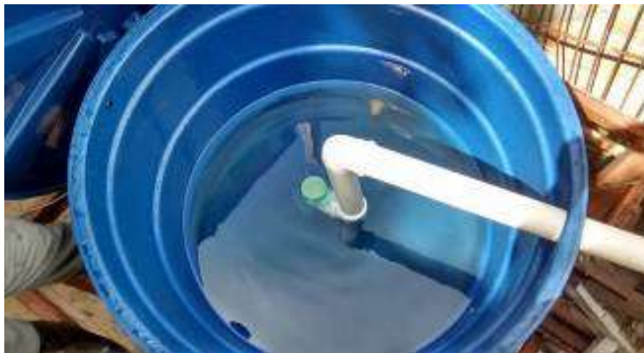
Figura 5 – Reservatório com redutor de turbulência.
