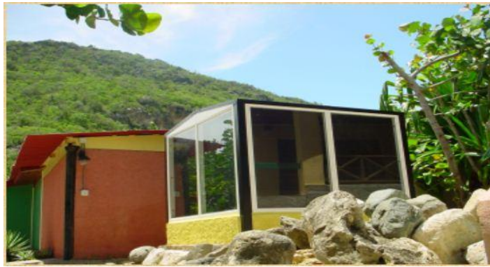
Foto 1: Sauna solar cubana. Foto: Centro de Investigaciones de Energía Solar de Cuba (CIES, CITMA)
