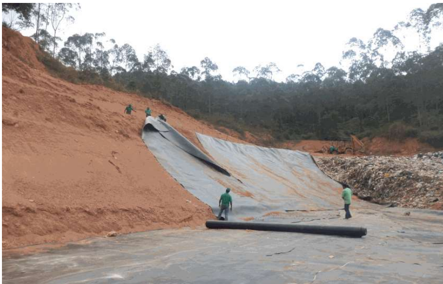
Figura 8: Geomembrana PEAD 2 mm Sendo Instalada no Aterro Sanitário do CPGRS
