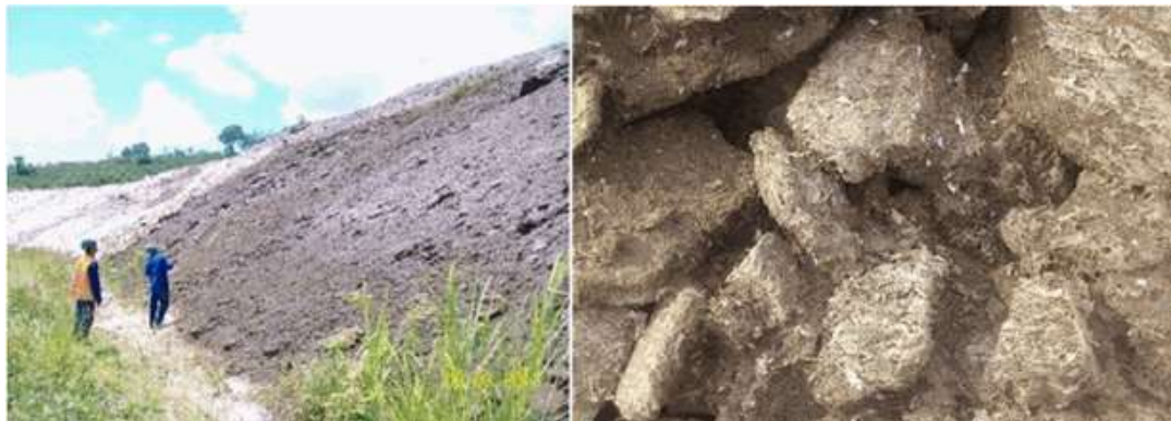
Figura 3 Aplicação da Manta Vegetal Projetada Dupla (Foto1) e Material rochoso coberto pela MVPD (Foto 2).
