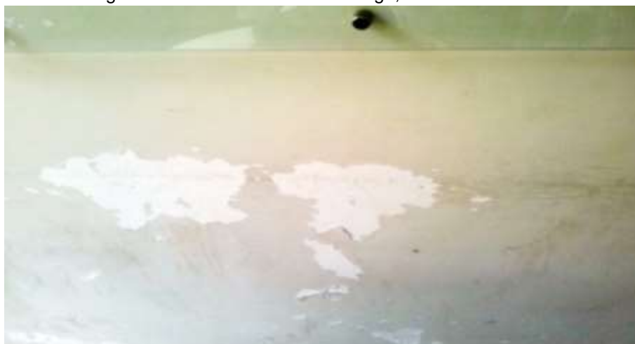
Figura 1 - Parede interna da FaEnge, tinta descascando
