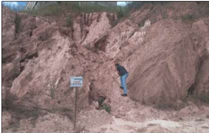
Figura 15: Erosão localizada na área de instabilidade
