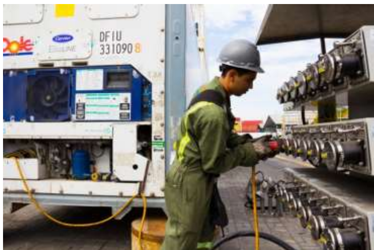
Figura 6 Conexión eléctrica de contenedores
