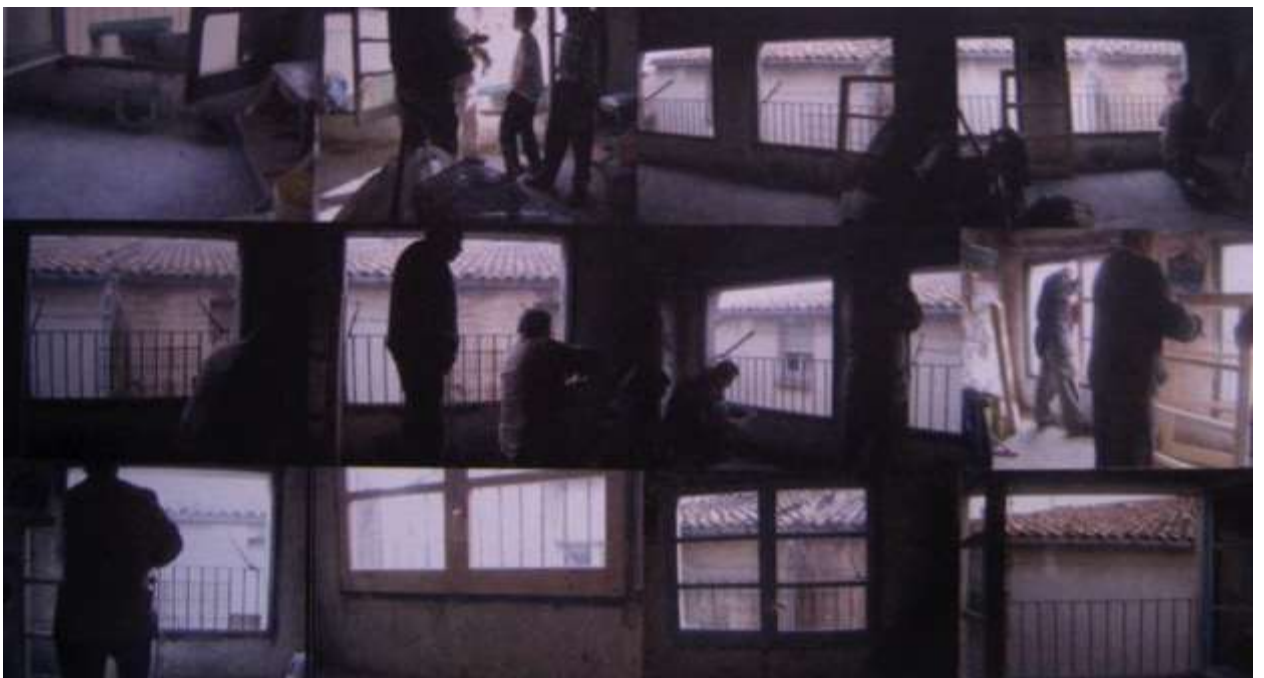
Intervención en la ventana de una casa del centro de Calaf.
