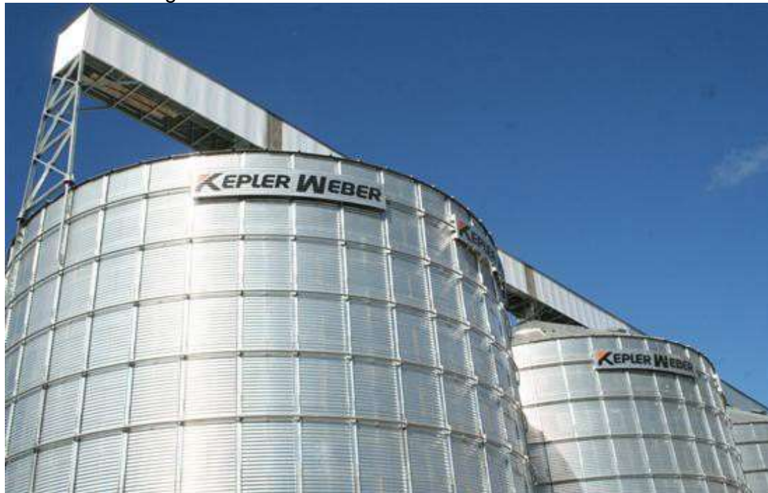
Figura 1: Armazém de grãos - Silo
