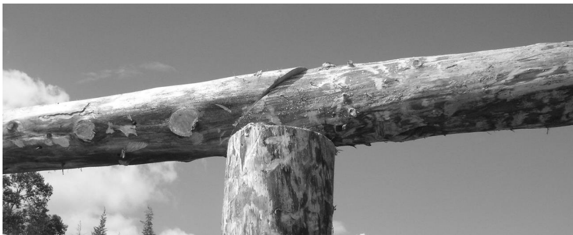
Figura 6. Unión de viga con apoyo sobre columna
