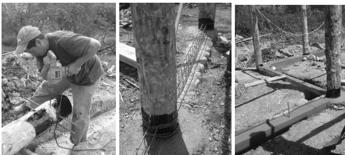
Figura 5. Anclaje de cimentación, columna de madera con amarre de cadena
