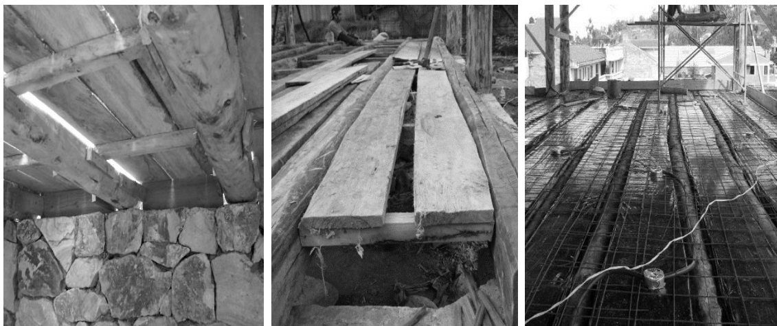
Figura 7. Armado de encofrado para entrepiso
