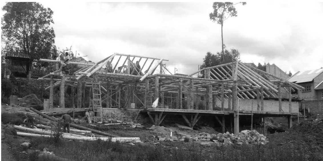
Figura 4. Composición estructural aporticada de la vivienda
