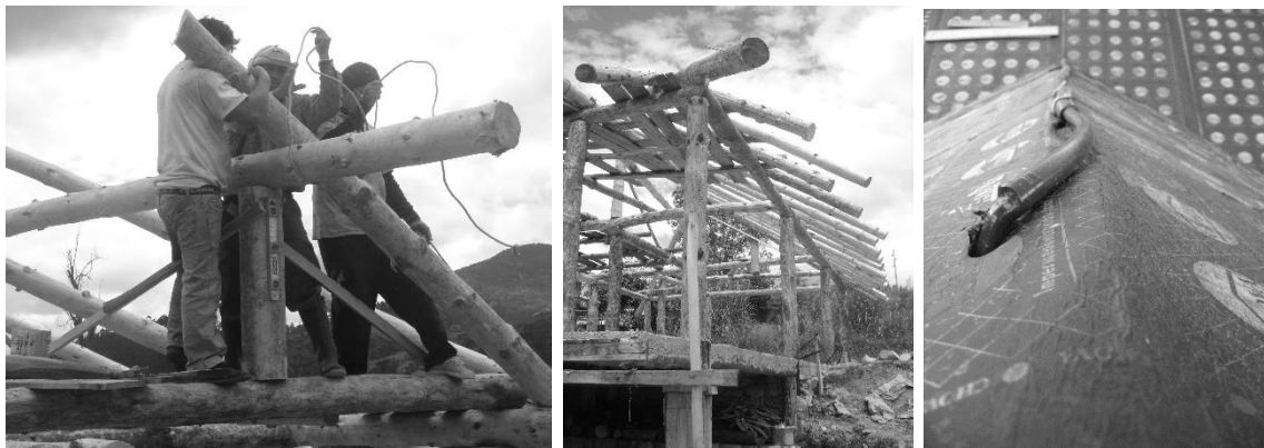
Figura 9. Armado de cubierta
