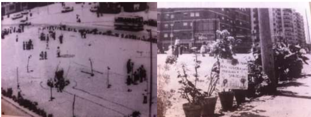
Imagen 10 y 11. Espacio delimitado por macetas de la actual Plaza Fontiveros.
