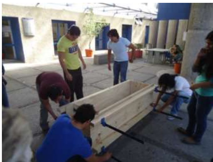
Fig. 2. Armado del Molde de Tapial Foto. Rafael González Alejo.
