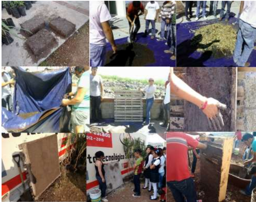
Figuras 11 a 15 Adobes aligerados y proceso de elaboración de panel demostrativo
