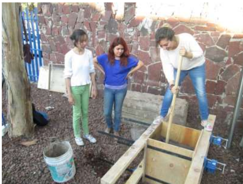
Fig. 4. Apisonado de capas de arcilla-arena húmeda Foto. Rafael González Alejo.
