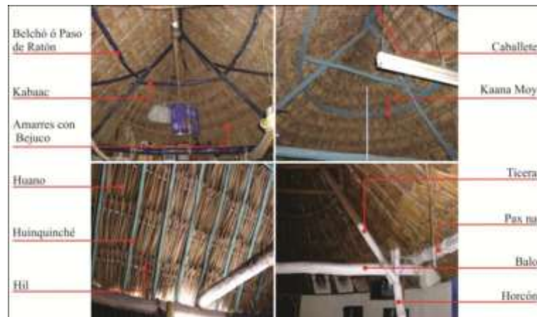
Figura 6. Materiales de la estructura de la cubierta Tomado de: Marisol Ordaz Tamayo
