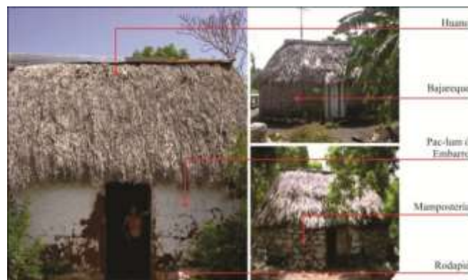
Figura 5. Materiales de los muros de la casa maya Tomado de: Marisol Ordaz Tamayo
