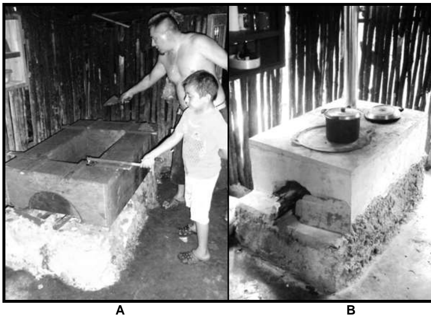
Figura 2. Proceso constructivo de EDL de grupo 2. (A) Construcción de cámara de combustión. (B) EDL terminada.
