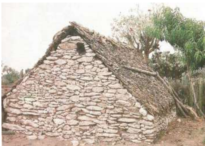
Figura 1. Casa construida con tepetate y cubierta de pencas de maguey. (López, 1993: 390).
