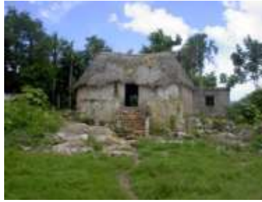
Figuras 11. Casa maya con secciones de paredes de block en Tahdziú, Yucatán Foto de: Adrián Contreras
