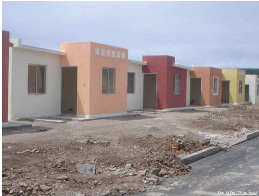
Figura 5.- Casas del Fraccionamiento Real del Desierto.
