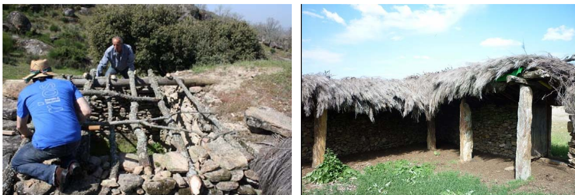
Fig.7 - Cubertura del chozo de pastor con escobas
