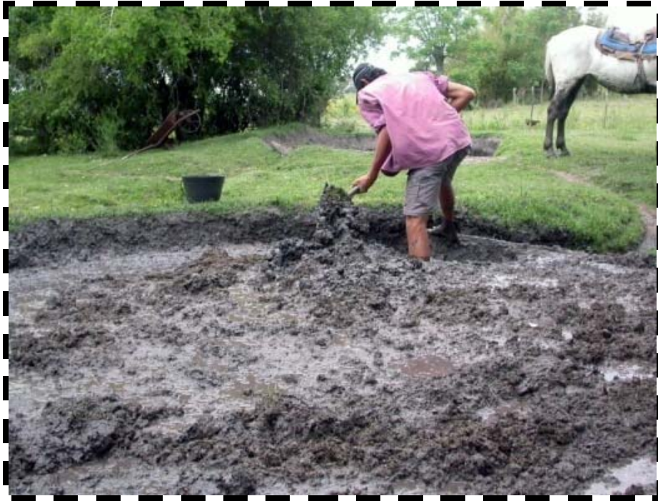
Fotografía -Luis mezclando la tierra, con la bosta y el agua en el pisadero
