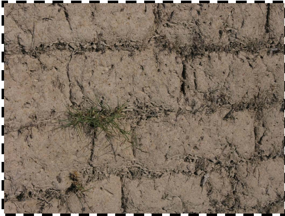
Fotografía -Detalle de una pared de terrón.
