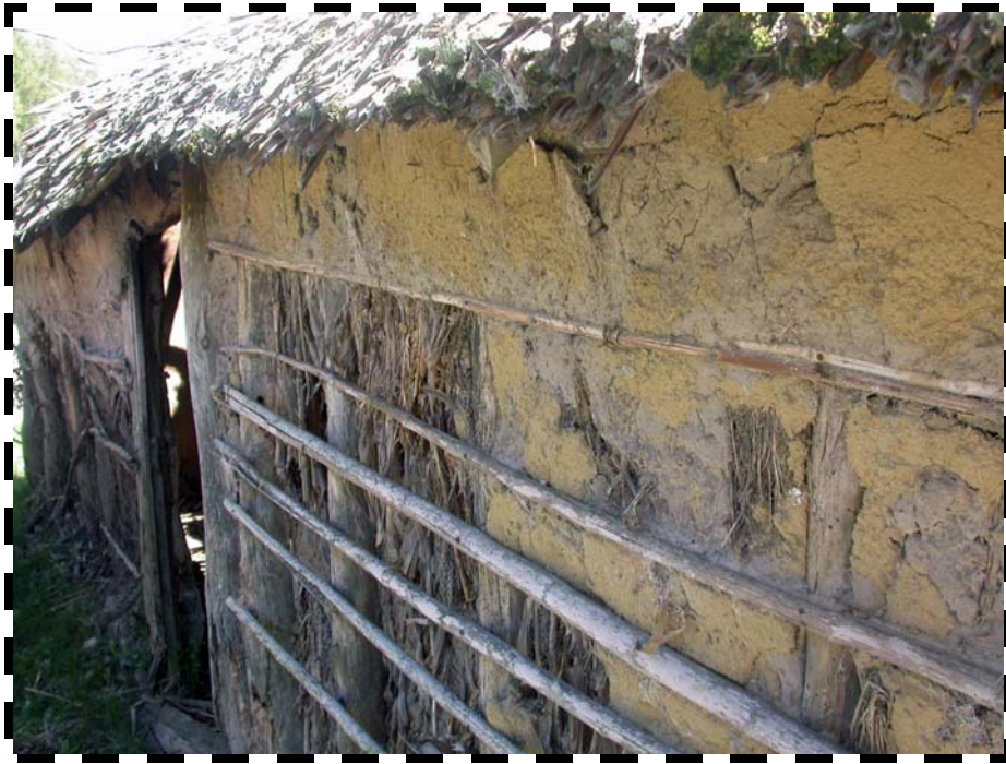
Fotografía -Técnica constructiva "palo a pique"
