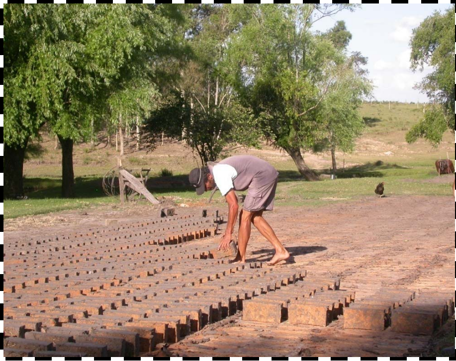
Fotografía -Luis secando los ladrillos crudos en la "cancha".
